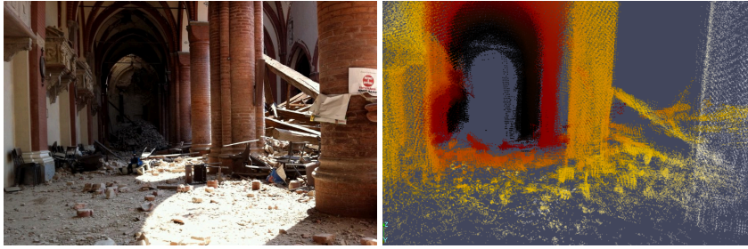
FIG. 3.9: Comparaison entre une photographie et la reconstruction 3D. À gauche : photographie de la galerie ouest pris depuis l'entrée ; à droite : vue de face de la reconstruction. (Repris de (POMERLEAU, COLAS et SIEGWART, 2015).)
