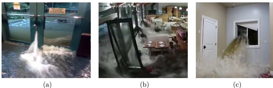
FIGURE 1.4 : Ouvertures détériorées lors d'inondations. (a) Écoulement à travers une fente entre deux portes à l'entrée d'un bâtiment (Source : Institut National pour la Recherche pour l'Agriculture, l'Alimentation et l'Environnement (INRAE) d'après Mignot, E., présentation du 19/05/2022 dans le cadre d'une rencontre de l'équipe de l'ANR DEUFI). (b) Crue éclair à Venise qui brise les ouvrants dans un restaurant, 29 octobre 2018, Italie ( https://www.youtube.com/watch?v=JleNixYqbTo ). (c) Inondation par une fenêtre rompue sous l'effet de la pression de l'eau, 5 septembre 2020, USA, ( https://www.youtube.com/watch?v=emnA7QD0h4k ).
