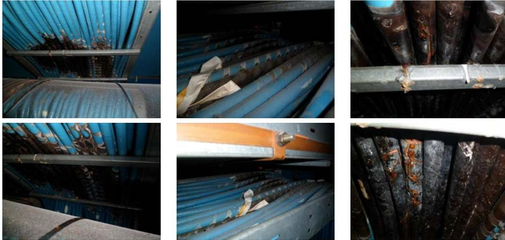
FIGURE 1.2: Câbles localement endommagés (images EDF)
