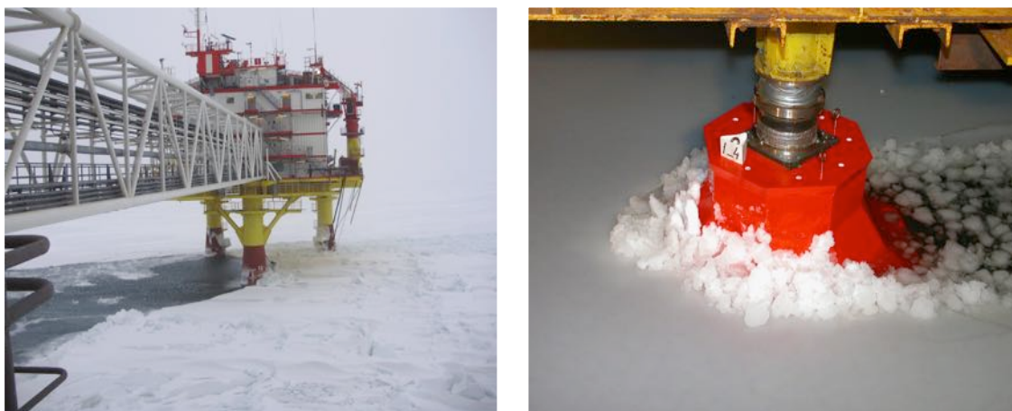
FIGURE 5.1 – Structures offshore en milieux polaires – Le dimensionnement est un point critique de la conception des structures offshore pour les milieux polaires. En effet, ces dernières doivent supporter d'importants efforts dus aux glaces dérivantes, comme illustré à gauche. L'industrie pétrolière se base généralement sur des recommandations d'experts qui relèvent d'observations de terrains. Des essais en bassin (à droite) viennent compléter ces lois empiriques, mais ils ne peuvent être exhaustifs en raison du grand nombre de paramètres en jeu. Source : [Barkov, 2011]
