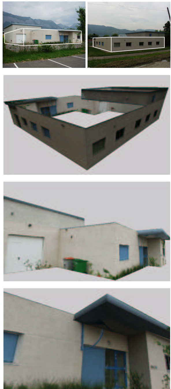
FIG. 5 – Le bâtiment suivant deux points de vue opposés (en haut) et des images du modèle construit.
