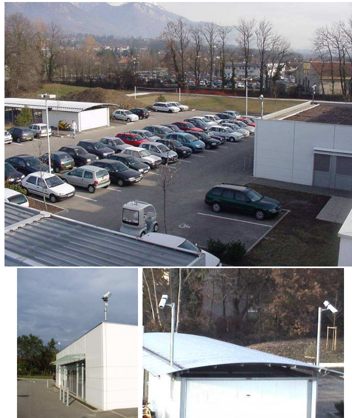
FIG. 4.1 – Parkview : le parking arrière de l'INRIA
