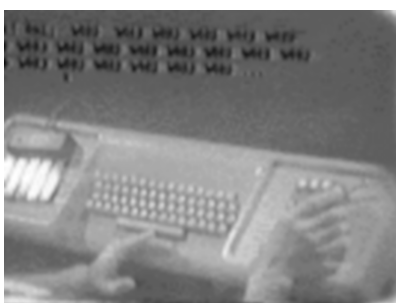
Clavier du système NLS, avec le « chord keyboard » sur sa partie gauche et la souris sur sa partie droite.
